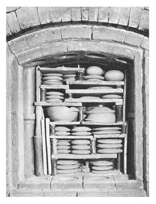
Die fertiggeformten, lufttrockenen Gegenstände zum Erstbrand (Verglühbrand) im Brennofen eingesetzt. Nach diesem Brand können die Tonwaren nicht mehr mit Wasser aufgeweicht werden
