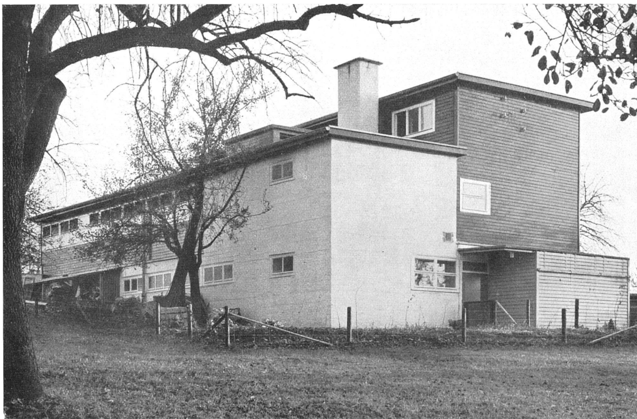
Ansicht von Norden. Links Werkstatt, im unverputzten Betontrakt die Brennöfen, im Anbau rechts Rohtonvorräte Keramische Werkstätte F. Haussmann, Uster (Kt. Zürich) Max Ernst Haefeli, Architekt BSA, Zürich
