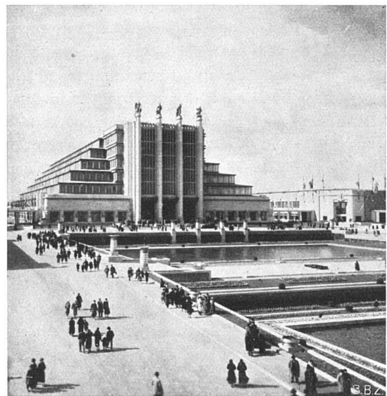
Das «Grand Palais» der Ausstellung 12 freitragende Dreigelenkbogen, Spannweite 86 m, Axenabstand 12 m, Stichtiefe 31 m, Grundfläche 14 220 m 2
