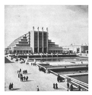
Das «Grand Palais» der Ausstellung 12 freitragende Dreigelenkbogen, Spannweite 86 m, Axenabstand 12 m, Stichhöhe 31 m, Grundfläche 14 220 m $^{\circ}$
