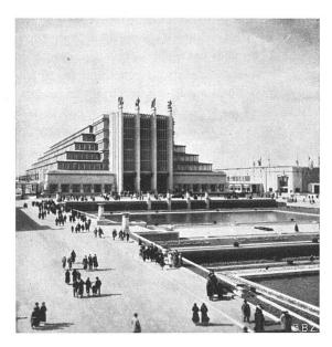
Das «Grand Palais» der Ausstellung 12 freitragende Dreigelenkbogen, Spannweite 86 m, Axenabstand 12 m, Stichhöhe 31 m, Grundfläche 14 220 m²
