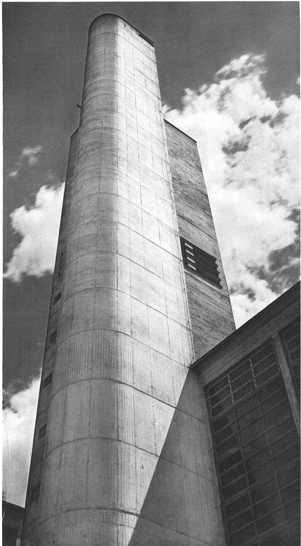
Hochkamin, mit dahinter angebautem Kühlturm, rechts Kesselhaus
