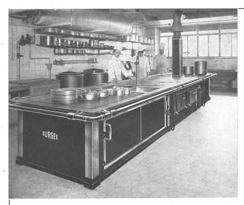
Restaurant Markthalle, Basel: Sursee-Grossgasherd, 5600 mm lang, kombiniert für Pressluft- und Niederdruck-Gasbeheizung
