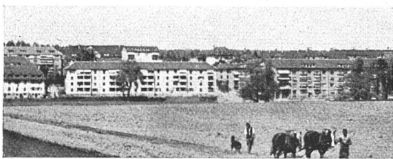
Blick vom Fischermätteli gegen das Holligengut Miethausblöcke mit unausgebautem Dachgeschoss; verglichen mit dem Mansardendach links, die sauberere einfachere Lösung. Die Bauten wirken leichter und offener
