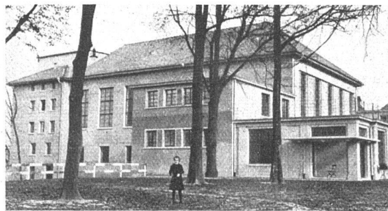
Der neue Fest- und Theatersaal der Kursaal Schänzli A.-G. Bern. Mitte November ist der Neubau eröffnet worden. Westseite. Architekt: Albert Gerster.
