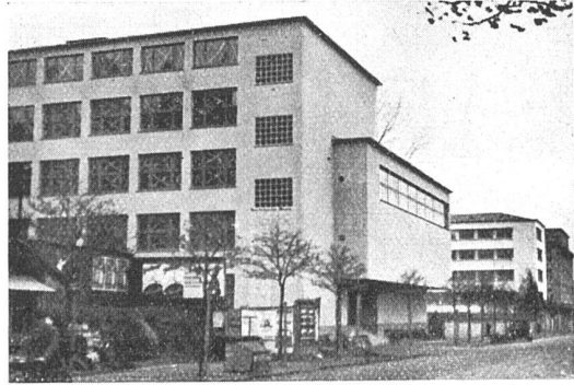
Der Neubau des Naturhistorischen Museums geht seiner Vollendung entgegen. Architekten Krebs und Müller . Bausumme, ohne Möblierung 1,3 Millionen. Im Hintergrund die neue Landesbibliothek. (Bernastrasse im Kirchenfeld.)
