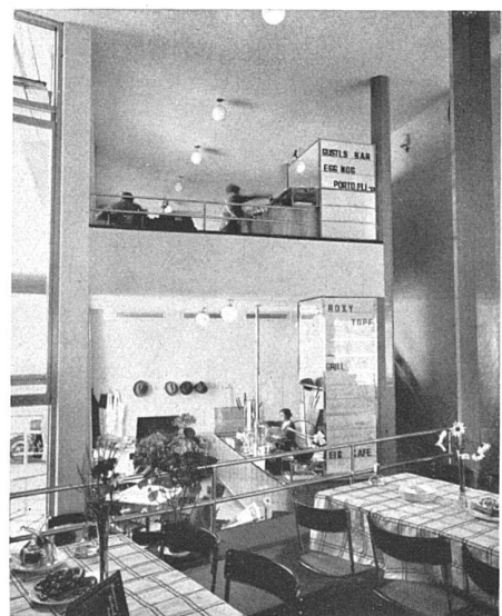
Z-Restaurant, Ecke Rebgrasse-Müllerstrasse Aeusserste Ausnützung der sehr ungünstig geformten Eckparzelle. Rund 140 Sitzplätze in drei Höhenlagen, das Podium im Vordergrund ermöglicht gute Belichtung und Belüftung der darunterliegenden vollelektrisch eingerichteten Küche
