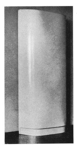
Gebogen verleimter Zylinder aus Sperrholz, aus dem die Sesselwangen geschnitten werden
