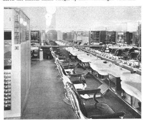
Kabinen (Lausanne), von oben gesehen, mit teilweise verspiegelten Schiebefenstern als Spiegelfront, indirekte Beleuchtung, rückwärts der Kabinen Kanalkonstruktion für Luft- und elektrische Leitungen, Abteilungswände unten mit Tischinlaid belegt, oben geätztes Rohglas in Anticorodalrahmen, Schiebetüren
