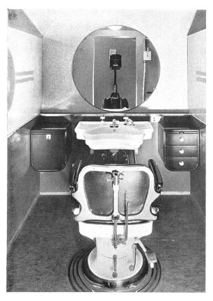
Coiffeurkabine in einem Damensalon Waschtisch mit versenkbarer Batterie, die Spiegelfläche freilassend. Seitenkästehen schwarz Nitroschleiflack, Wandbelag auf Brüstung und Abteilungswänden rot Tischinlaid, Gläser Rohglas geätzt und gesandet, in Anticorodalrahmen
