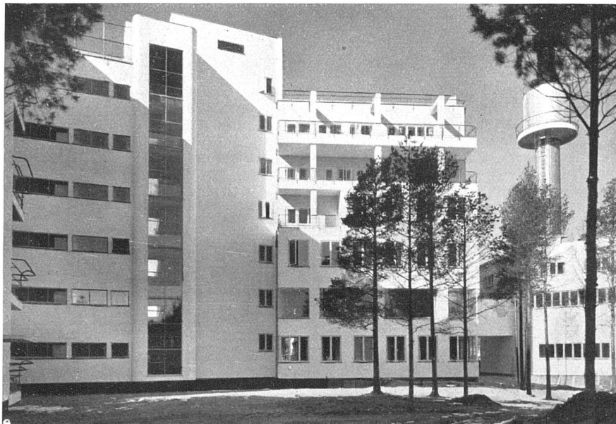
Ansicht von Osten Treppenhaus und Gemeinschaftsflügel, rechts Oekonomieflügel
