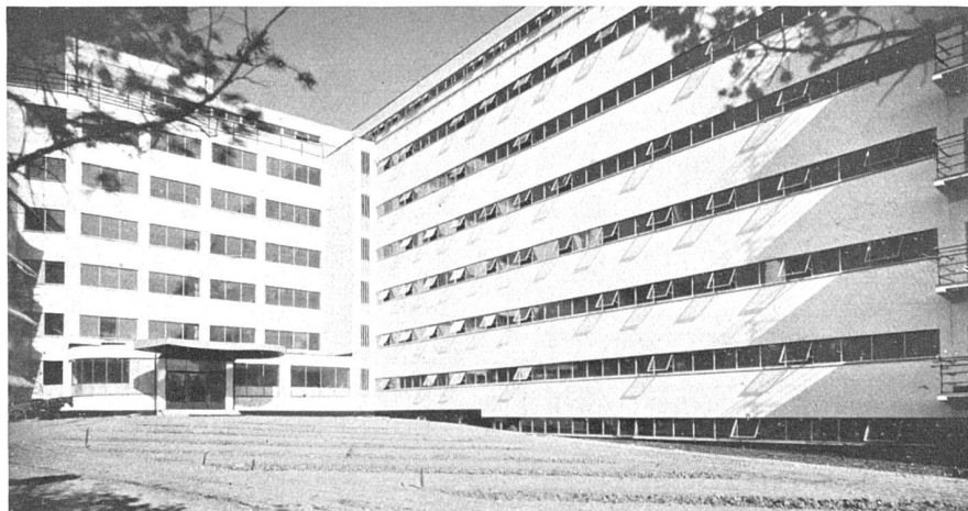
Hofansicht aus Nordwesten Haupteingang, rechts Gangseite des Bettentraktes
