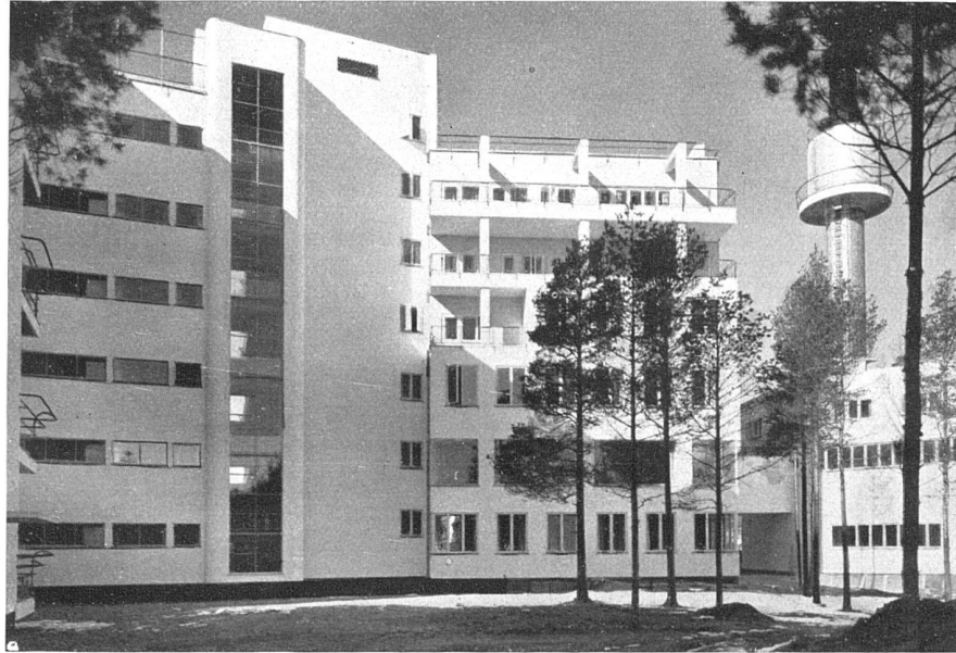
Ansicht von Osten Treppenhaus und Gemeinschaftsflügel, rechts Oekonomieflügel
