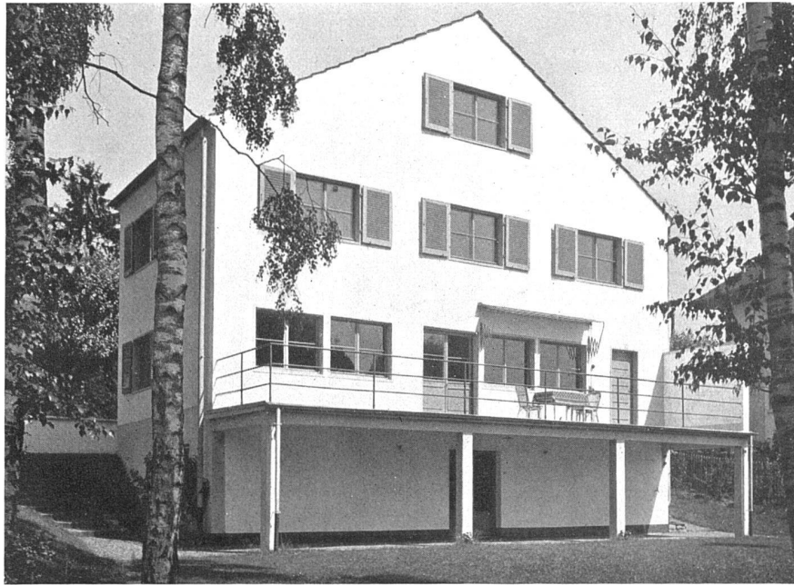
Ansicht aus Süden
