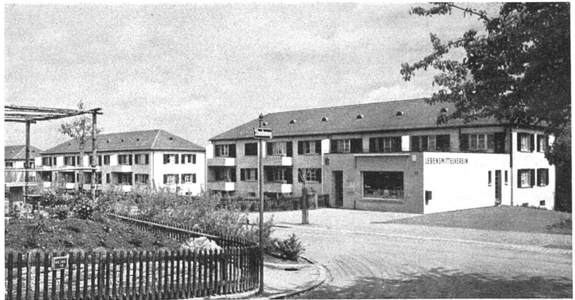
Schweighofstrasse, Blick aus Süden, Eckhaus mit Vorbau für den Lebensmitteladen
