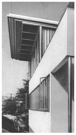
Soffittenlampen für die Wohnräume aussen im Dachüberstand, hiedurch keine Spiegelung in den Fenstern und Schutz vor Insekten auch bei geöffneten Fenstern
