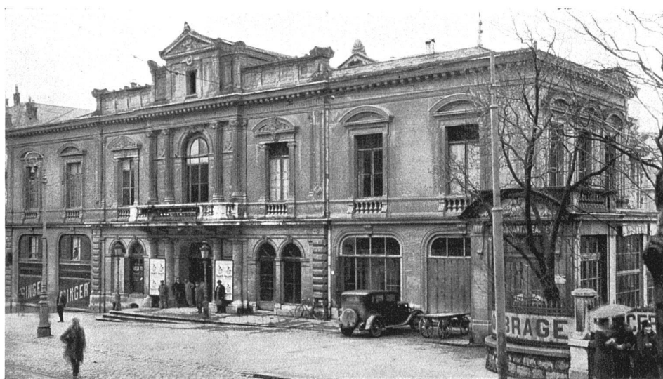
La façade vers l'avenue de la Gare avant la renovation
