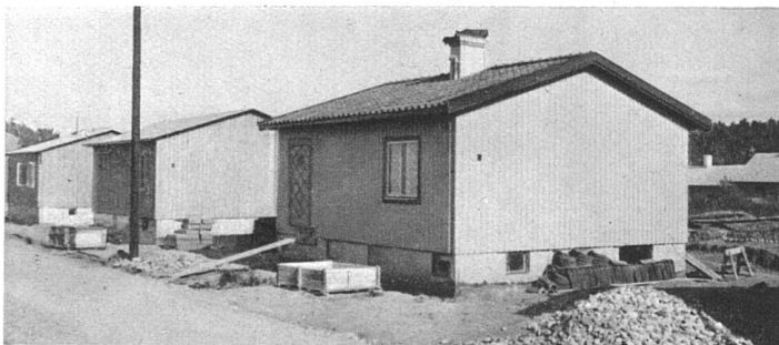
Häuser, Typ C, im Bau
