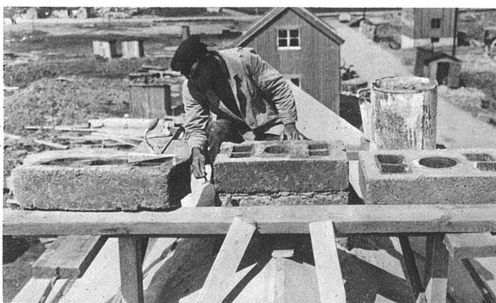
Kleinhaus, Typ A Der Kamin wird gemauert
