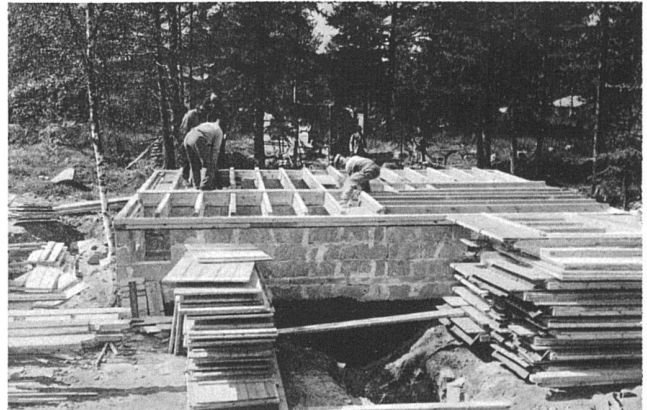
Man verlegt die Balkenlage
