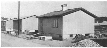
Zur Erleichterung der Errichtung der Kamine wurden diese aus G. sbetonblöcken mit eingefügten Steingutrohren für die Rauch- und Entlüftungskanäle geliefert. Diese Konstruktion, der anfänglich etwas Misstrauen entgegengebracht wurde, hat
