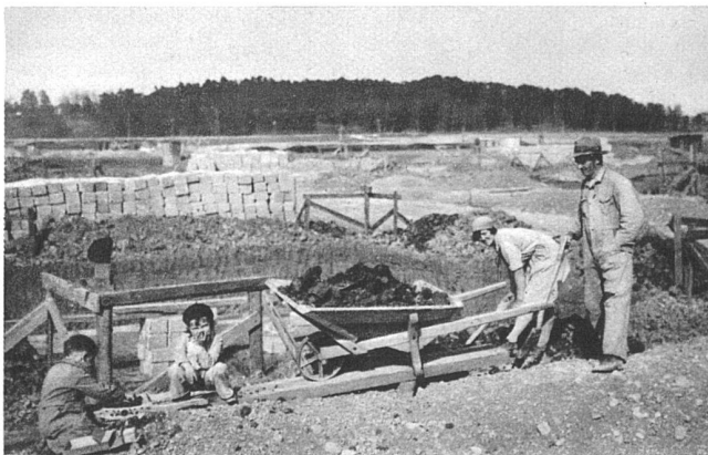
Die Siedler heben die Baugrube aus
