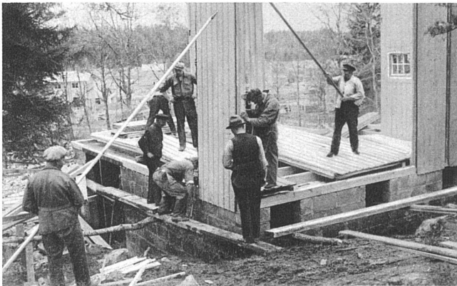
Die Wandplatten werden aufgestellt
