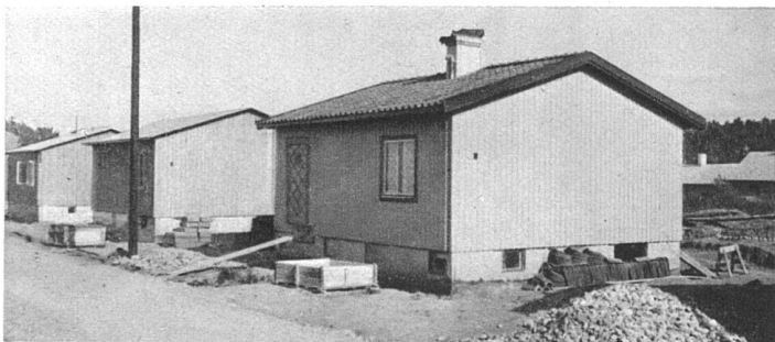
Häuser, Typ C, im Bau
