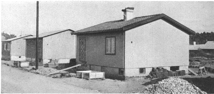
Häuser, Typ C, im Bau
