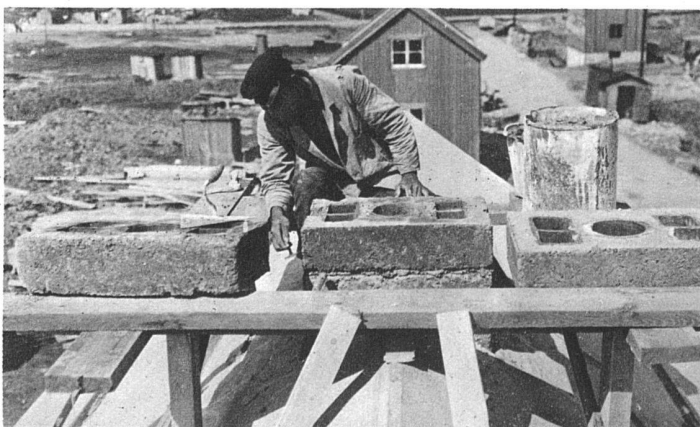
Kleinhaus, Typ A Der Kamin wird gemauert
