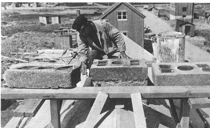
Kleinhaus, Typ A Der Kamin wird gemauert
