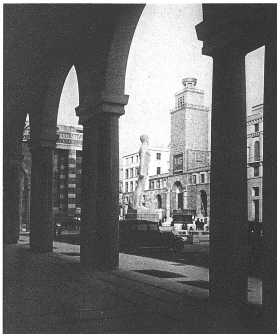
Brescia, Piazza della Vittoria Blick aus den Loggien der Südwestseite gegen das Postgebäude und die «Torre della Rivoluzione» La nouvelle place vue de Sud-Ouest
