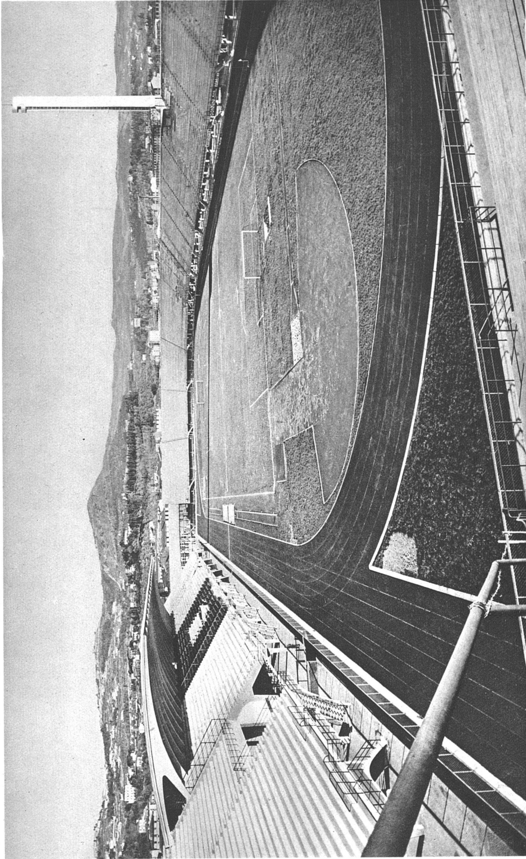
Stadion Giovanni Berta, Florenz Ingenieur Pier Luigi Nervi Achsen des Spielfeldes 272 und 144 m, im ganzen 35 000 Sitzplätze. Die 7,50 m breite Piste misst zwei gerade Strecken von 220 m und zwei Kurven mit inneren Radien von 39 m, äusserer Radius einschliesslich Tribünen 68,55 m Schnitte und Risse im Aprilheft 1933 der Monatschrift «Casa bella», Editoriale «Domus» S. A., Milano
