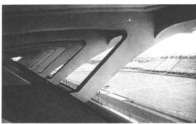
Haupttribüne für 6000 Zuschauer 110 m lang, stützenfreie Auskragung 22 m Die gedeckte Tribüne steigt in 26 Stufen zu  $0.70 \times 0.44$  m, die ungedeckte in 28 Stufen zu  $0.66 \times 0.40$  m. Im Tribünengebäude auf der Strassenseite Empfangs- und Aufenthaltsräume, Garderoben, Duschen, Arzt usw., vor der Tribüne die 200-m-Strecke
