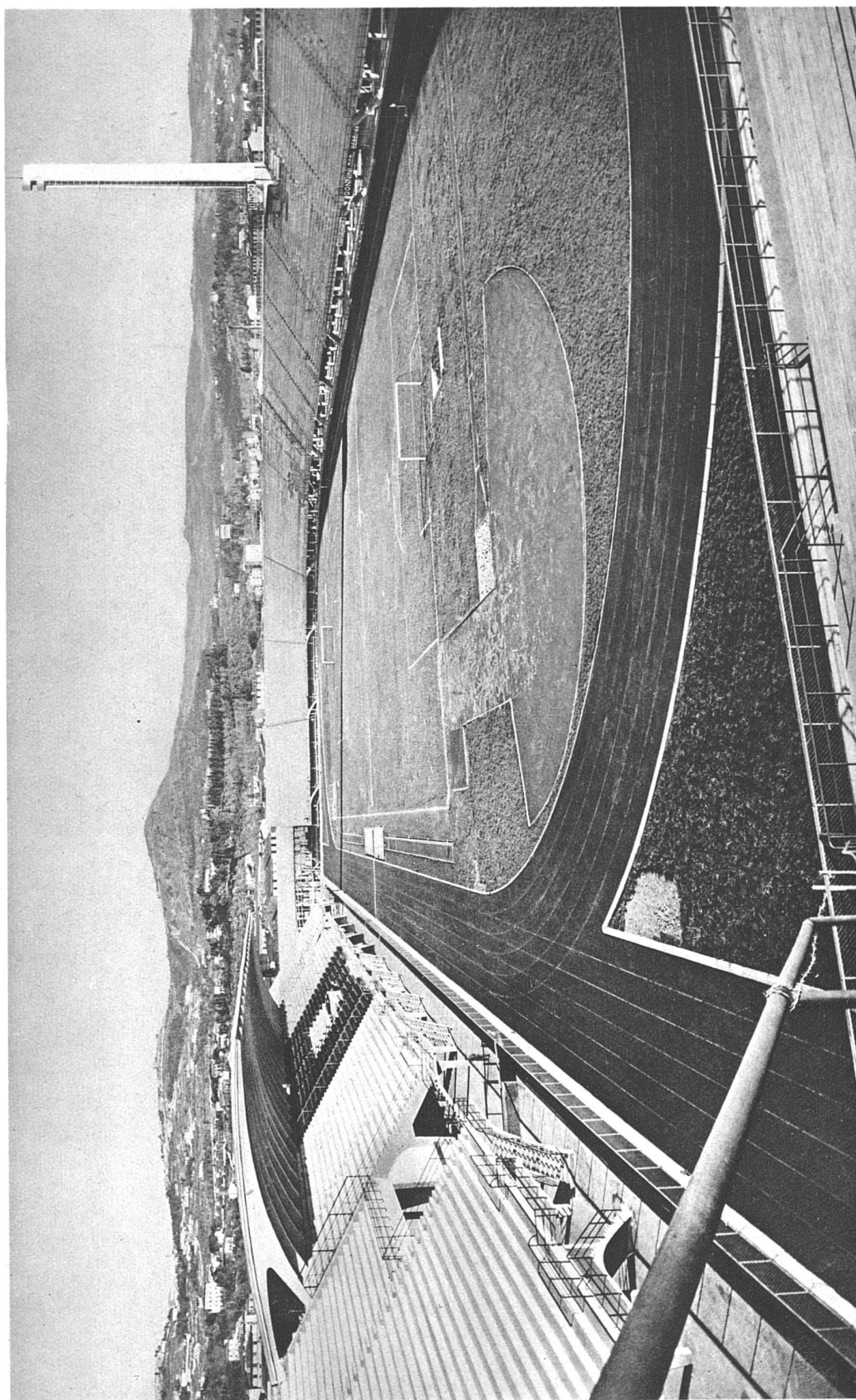
Stadion Giovanni Berta, Florenz Ingenieur Pier Luigi Nervi Achsen des Spielfeldes 272 und 144 m, im ganzen 35 000 Sitzplätze. Die 7,50 m breite Piste misst zwei gerade Strecken von 220 m und zwei Kurven mit inneren Radien von 39 m, äusserer Radius einschliesslich Tribünen 68,55 m Schnitte und Risse im Aprilheft 1933 der Monatsschrift «Casa bella», Editoriale «Domus» S. A., Milano
