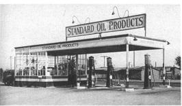
Tankstelle in Cleveland. Stützen und Decke aus Eisenbeton.
