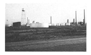
Petroleumraffinerie bei Detroit. Freiluftanlage zur Herstellung und Lagerung von Benzin. Stahlretorten, Hochkamine, Tanks, Wasserbehälter sind grundrisslich nach dem Fabrikationsschema angeordnet. Stahl ist durch Aluminiumfarbanstrich gegen Korrosion geschützt. Schöne Zweckformen in monotoner Gegend.
