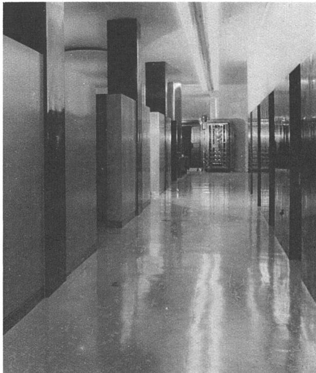
Couponkabinen Pfeiler und Kabinenwände mit dunkelbraunen Gummiplatten von 3 mm Dicke verkleidet
