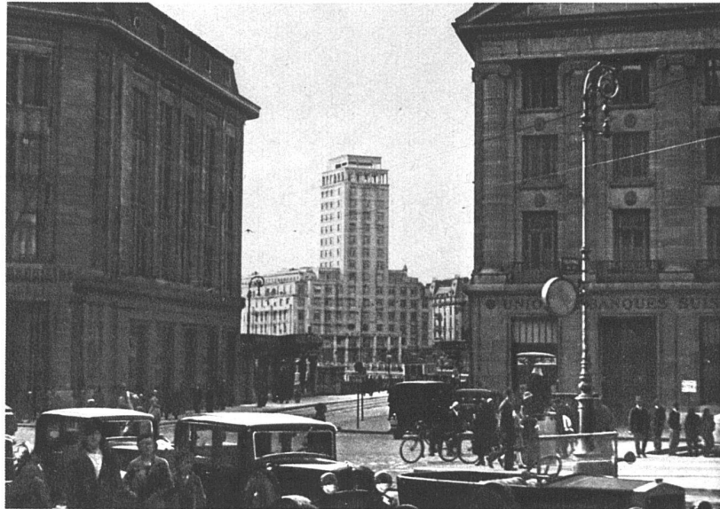
Immeuble Bel-Air-Métropole au delà du Grand-Pont vu de la Place St-François
