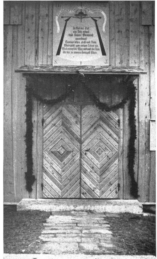
Portal, Vordach mit Schindeln gedeckt, Blechtafel
