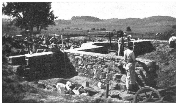
Rohbauaufnahmen, rechts Grundriss 1:200
