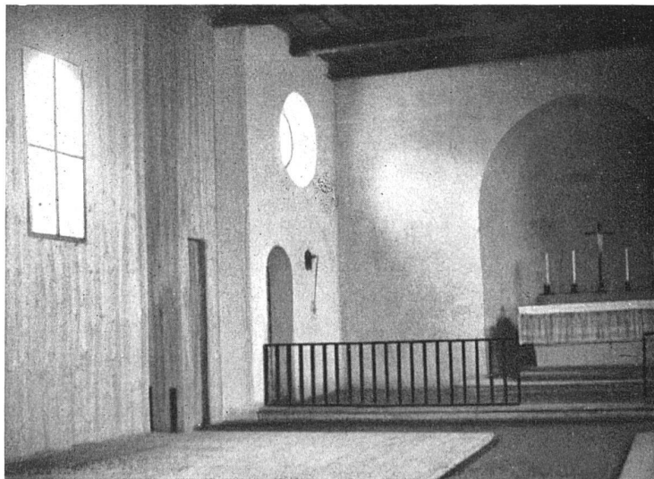
Inneres. Chor und Apsis Bruchsteinmauerwerk, innen mit Backstein vorgemauert und geweißt Als Altarnische echtes Backsteingewölbe. Als Decke die unverkleideten Konstruktionshölzer, darüber Bretterschalung, gehobelt und mit Ochsenblut gestrichen
