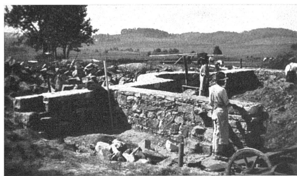
Rohbauaufnahmen, rechts Grundriss 1:200
