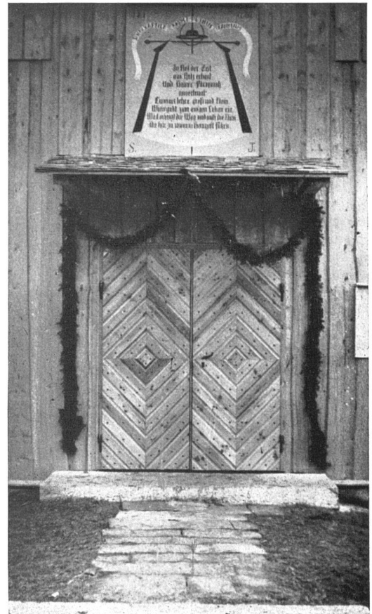
Portal, Vordach mit Schindeln gedeckt, Blechtafel
