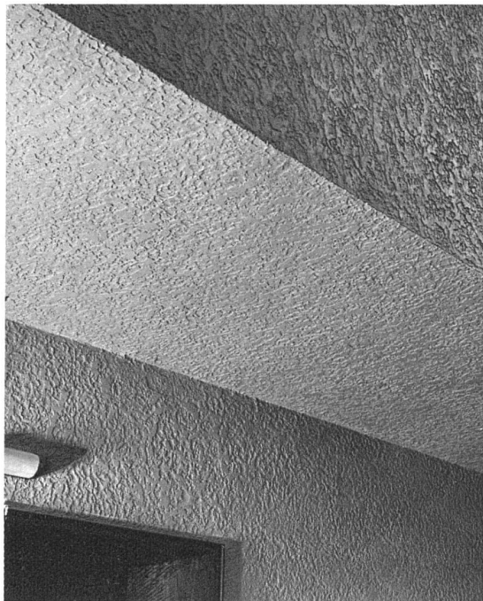
Grosser Saal Detail der Wandbehandlung mit «Craftex»
