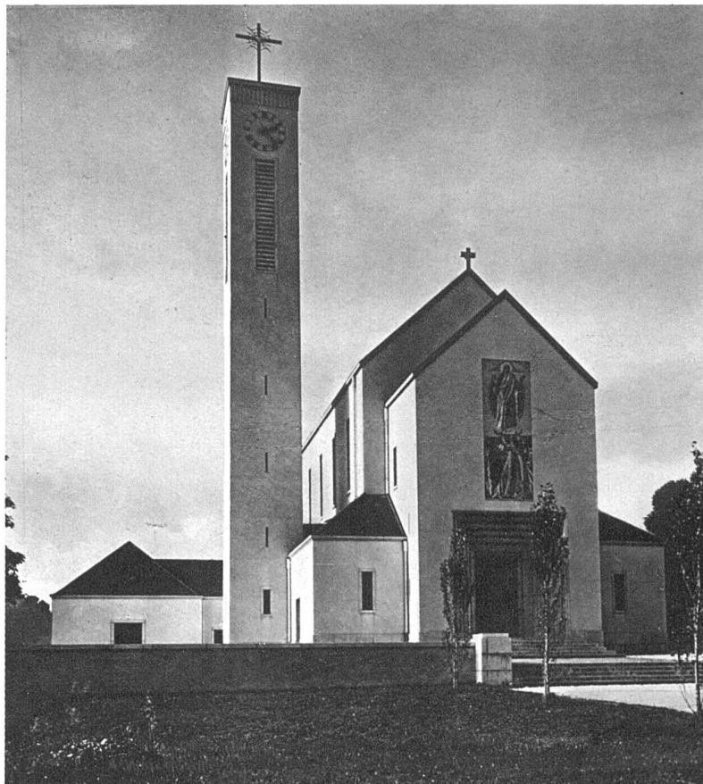
Eglise catholique romaine de Tavannes (Ct. de Berne) Adolphe Guyonnet, arch. FAS, Genève
