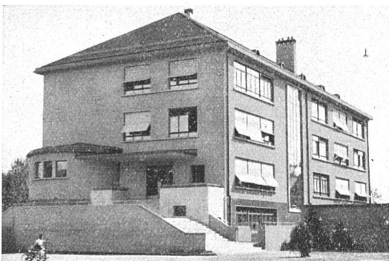
Schule für «Uebungsklassen» Ecke Muesmatt-Freiestrasse, Bern
