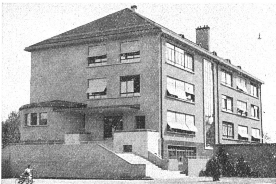
Schule für «Uebungsklassen» Ecke Muesmatt-Freiestrasse, Bern
