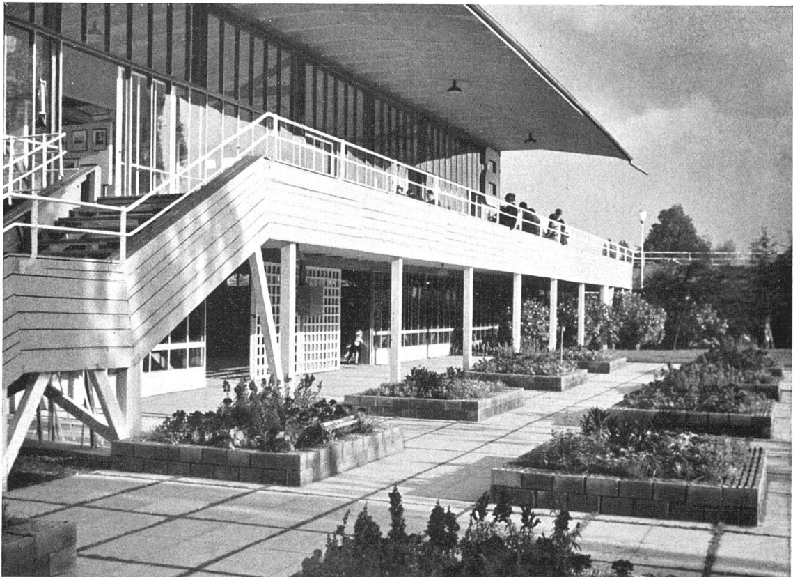
Zürcher Gartenbauausstellung «Züga» Carl Egender, Wilhelm Müller, Architekten BSA, Zürich, und Ing. Kägi in Firma Locher & Co., Zürich Halle 1, Verglasung in handelsüblichem Normalformat, mit Bleistreifen, also kein Glasverschnitt Die Scheiben werden nach Gebrauch vom Lieferanten zurückgenommen
