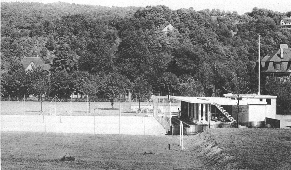
Ansicht aus Süden
