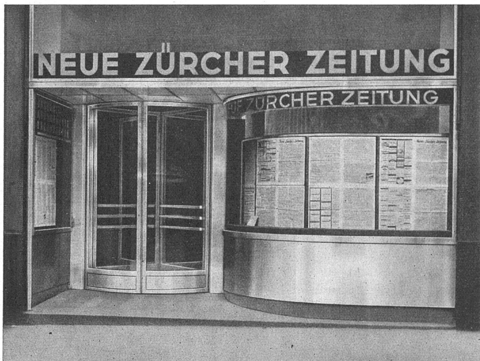
SCHAUFENSTERANLAGE MIT DREH- U. SCHIEBTÜRE IN ANTICORODAL AN DER BAHNHOFSTRASSE IN ZÜRICH (ARCH. A. C. MÜLLER)
