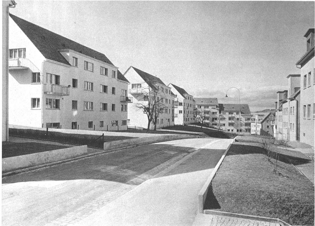
Siedlung Tannenrauch-Besenrainstrasse, Zürich 2, aus Südosten
