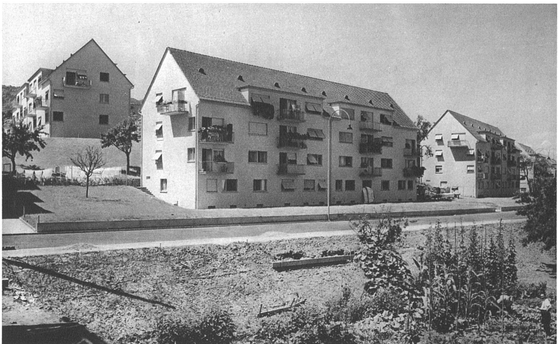
Siedlung Tannenrauch-Besenrainstrasse, Zürich 2, aus Osten
