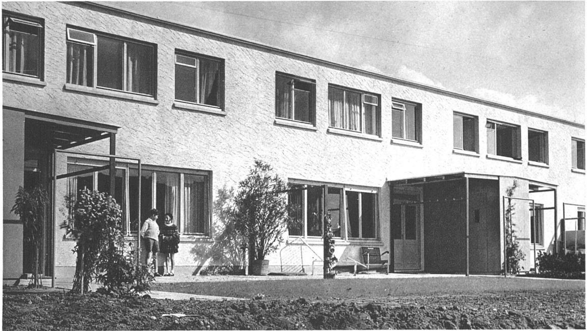
Reihenhäuser an der Fasanenstrasse, Eglisee Basel Arch. Hermann Baur BSA Gartenseite (Süden)
