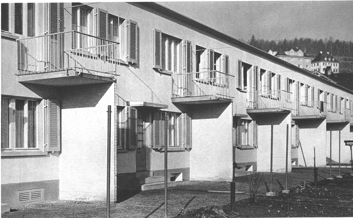
Ansicht aus Südosten
