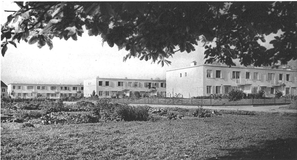
Ansicht aus Südosten
