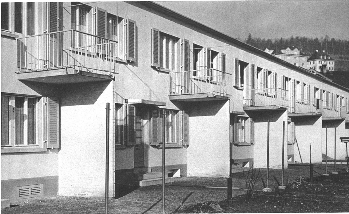
Ansicht aus Südosten
