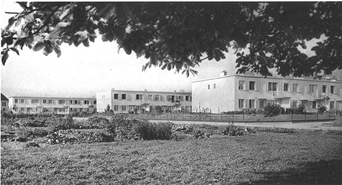
Ansicht aus Südosten
