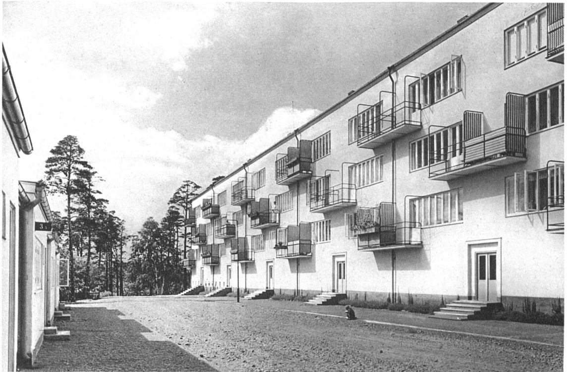
Die dreistöckigen Reihenhäuser aus Südosten gesehen
