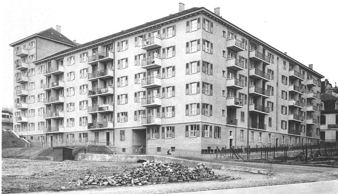
Vue prise de la route de Genève, angle sud-ouest
