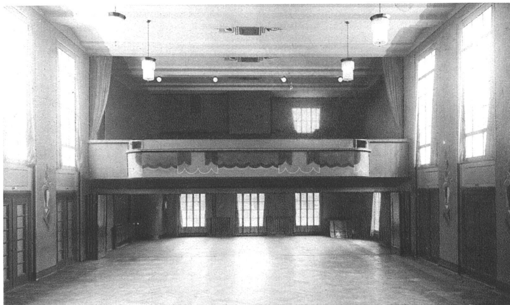
Hall d'entrée et vestiaires en bas: la grande salle vers la tribune
