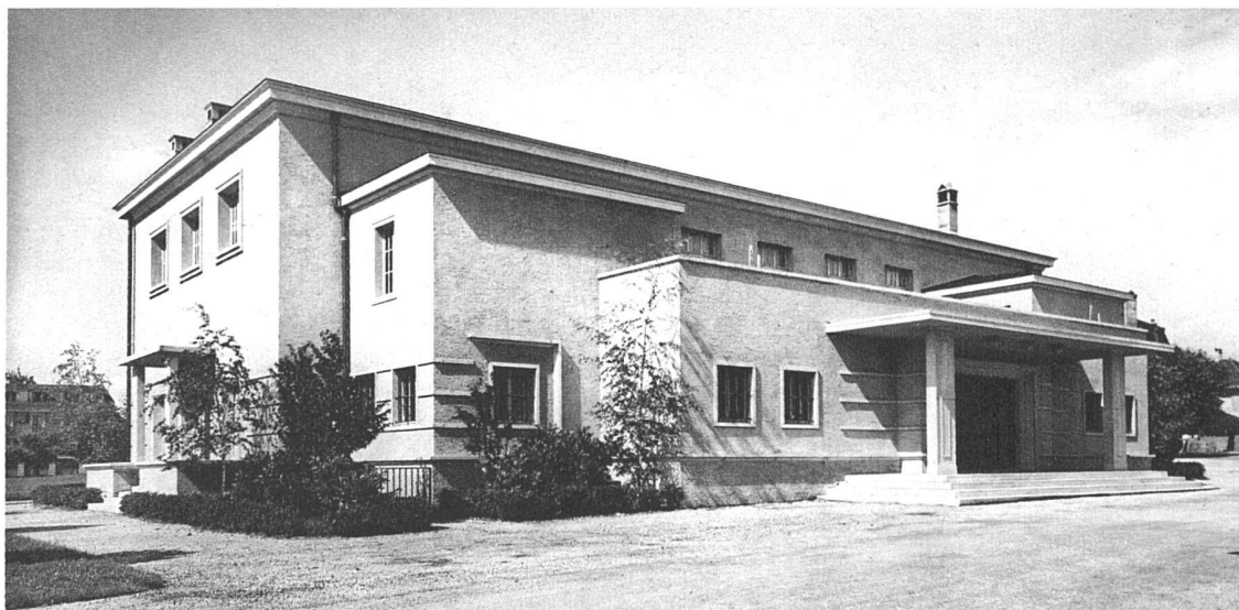
Vue de l'est, entrée principale
