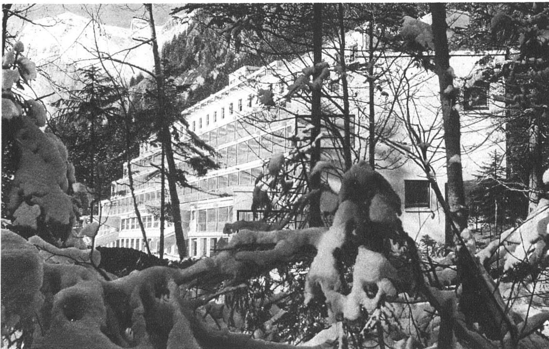
Ansicht von Südwesten, vorn rechts Pavillon C
