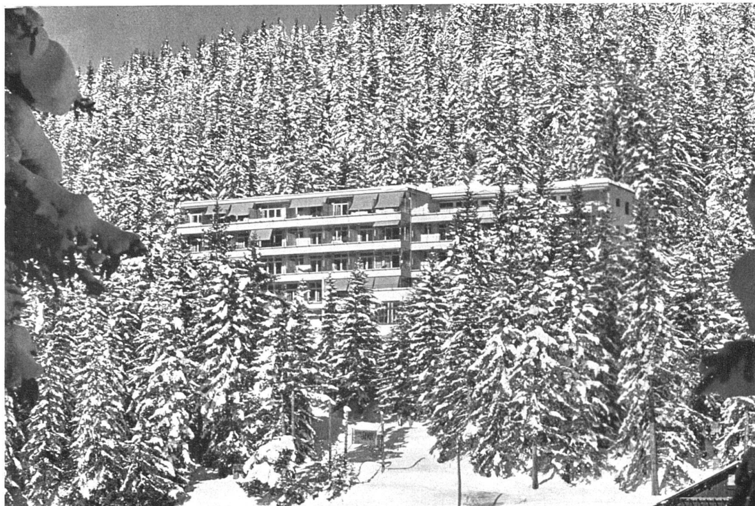
Sanatorium Bella Lui in Montana, Kt. Wallis Ansicht von Südosten Architekten A. Itten BSA, Thun, und R. und F. Steiger BSA, Zürich
