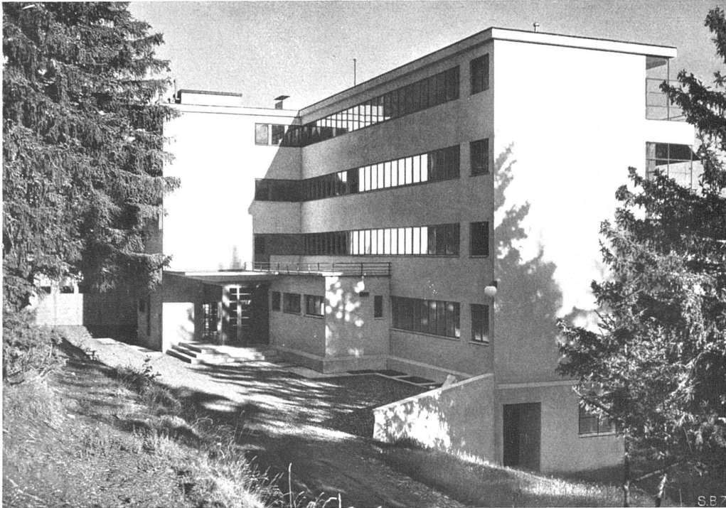
Sanatorium Bella Lui in Montana, Kt. Wallis Rückseite mit Haupteingang, von Westen gesehen Architekten A. Itten BSA, Thun, und R. und F. Steiger BSA, Zürich
