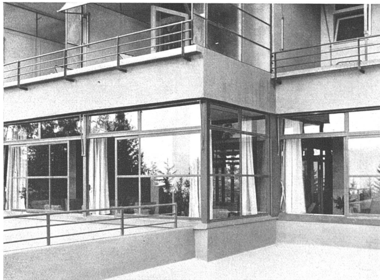
Blick von der Terrasse über dem Speisesaal gegen Musikzimmer und Halle
