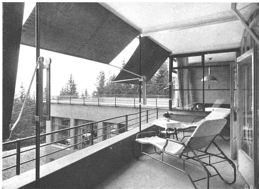
Privatterrasse der Direktorwohnung Blick auf Speisesaal
