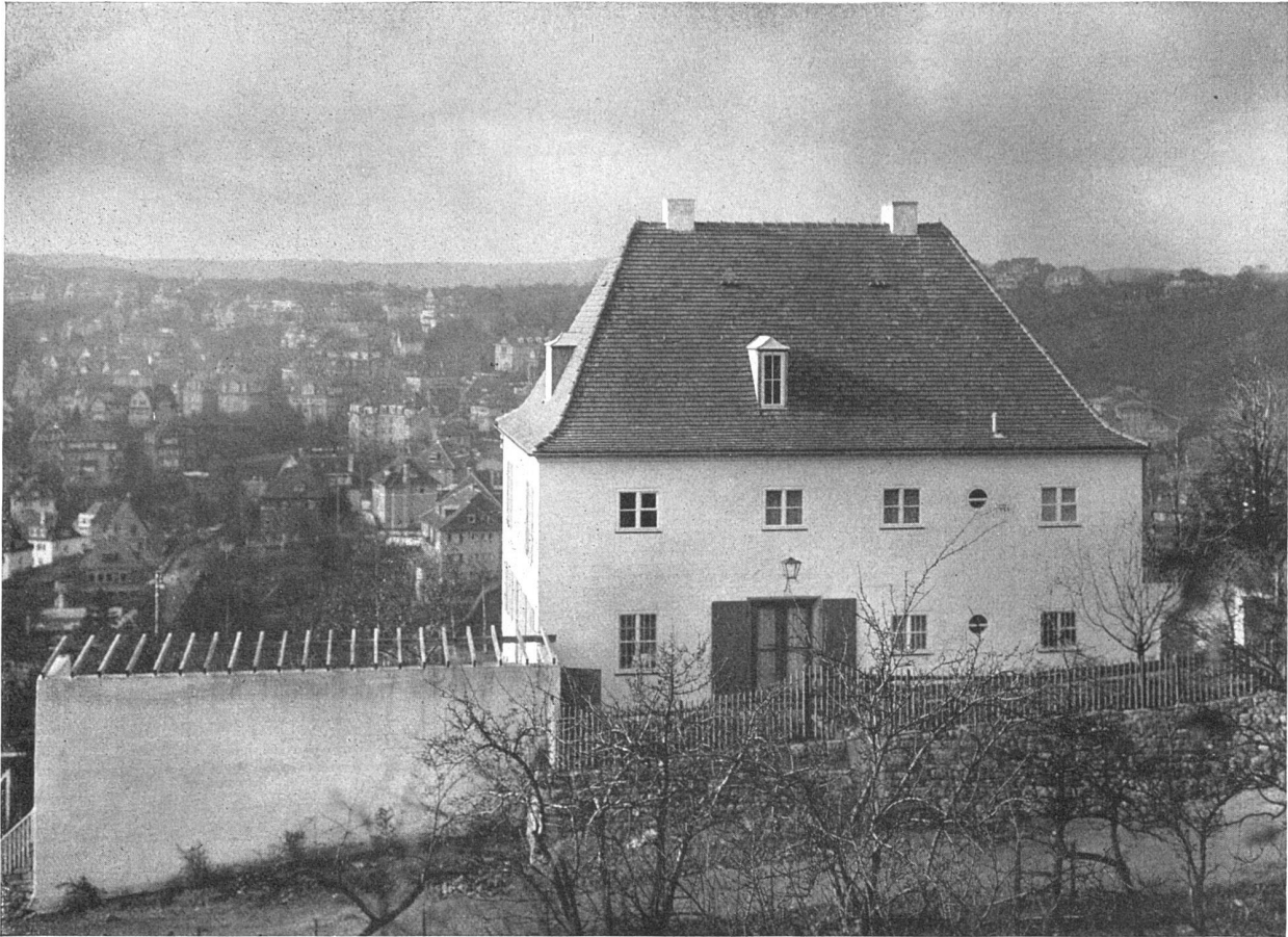
Arch. Paul Schmitthenner, Stuttgart. Haus D. in Stuttgart. Nordostseite vom Hohlweg aus, mit Haustüre
