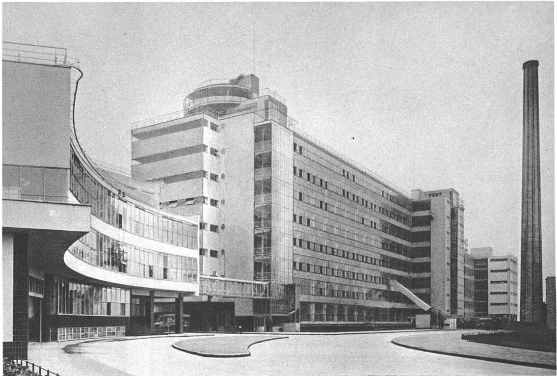
Gesamtansicht vom Haupteingang, links Kontorgebäude, rechts Kesselhaus
