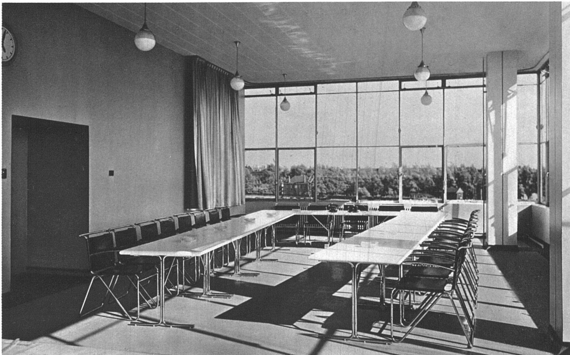
Sitzungszimmer im Kontorgebäude
