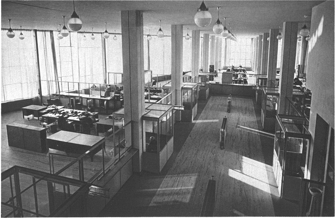
Grosse Schalterhalle im Erdgeschoss des Kontorgebäudes
