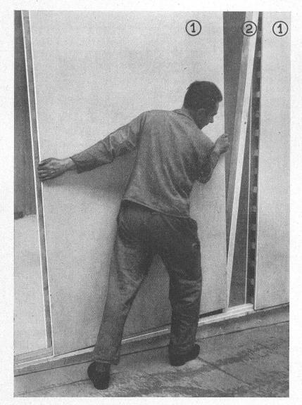
Zusammenbau von TRIUMPH-Bauelementen bei einer Zwischenwand
