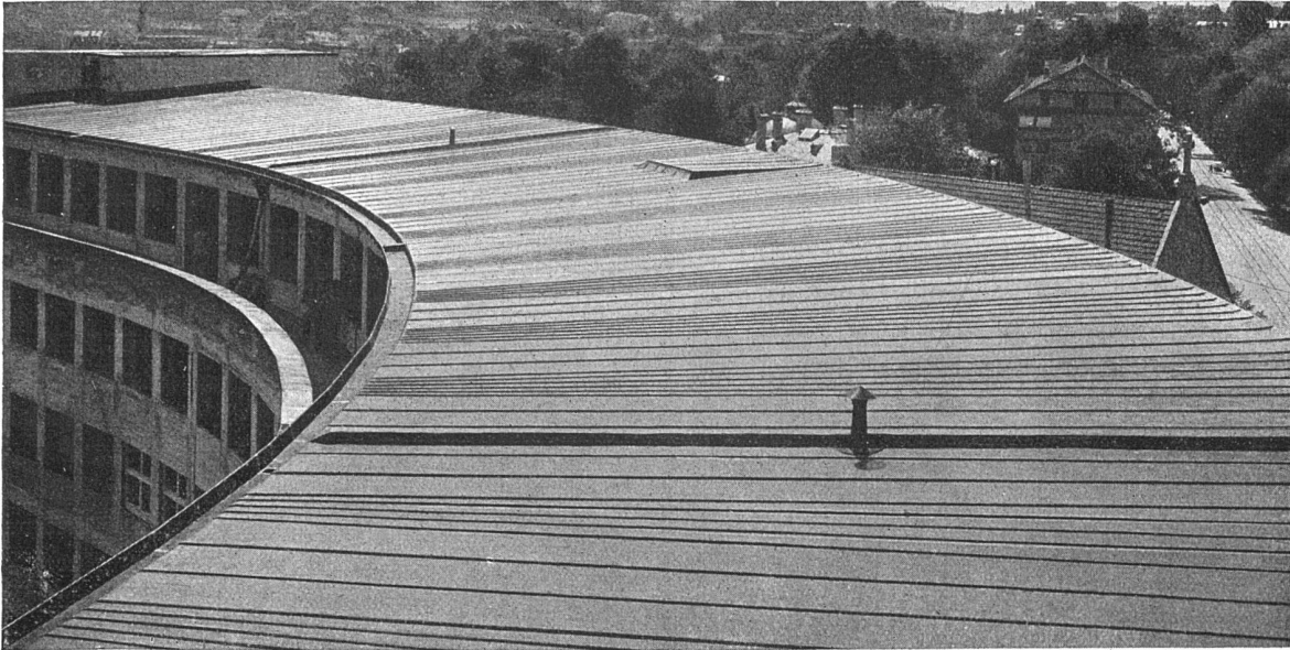
Verwaltungsgebäude der Schweiz. Unfall-Versicherungsanstalt Luzern in Bern (Arch. Salvisberg & Brechbühl, Bern) ca. 720 m 2 Tecuta 0,3 mm
