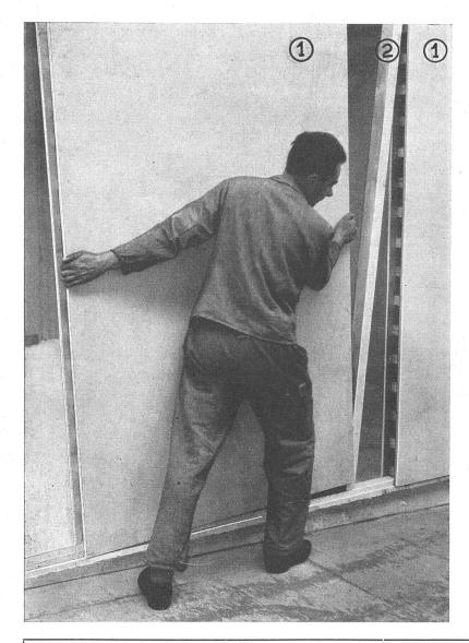
Zusammenbau von TRIUMPH-Bauelementen bei einer Zwischenwand
