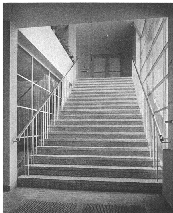
Treppe zum Saal, Fenster doppelt verglast in Eisenrahmen
