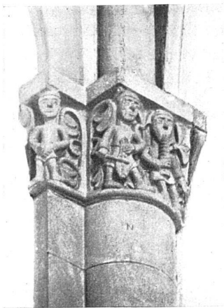
Südliches Kämpfergesims des Triumphbogens und seine als Dienstkaptäl im erhöhten Chorgewölb wiederverwendete Fortsetzung
