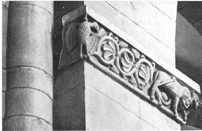
Südliches Kämpfergesims des Triumphbogens und seine als Dienstkaptäl im erhöhten Chorgewölb wiederverwendete Fortsetzung
