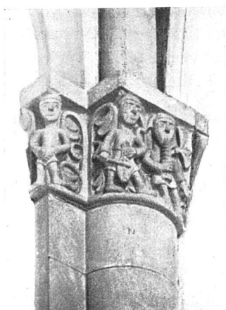
Südliches Kämpfergesims des Triumphbogens und seine als Dienstkaptäl im erhöhten Chorgewölbe wiederverwendete Fortsetzung
