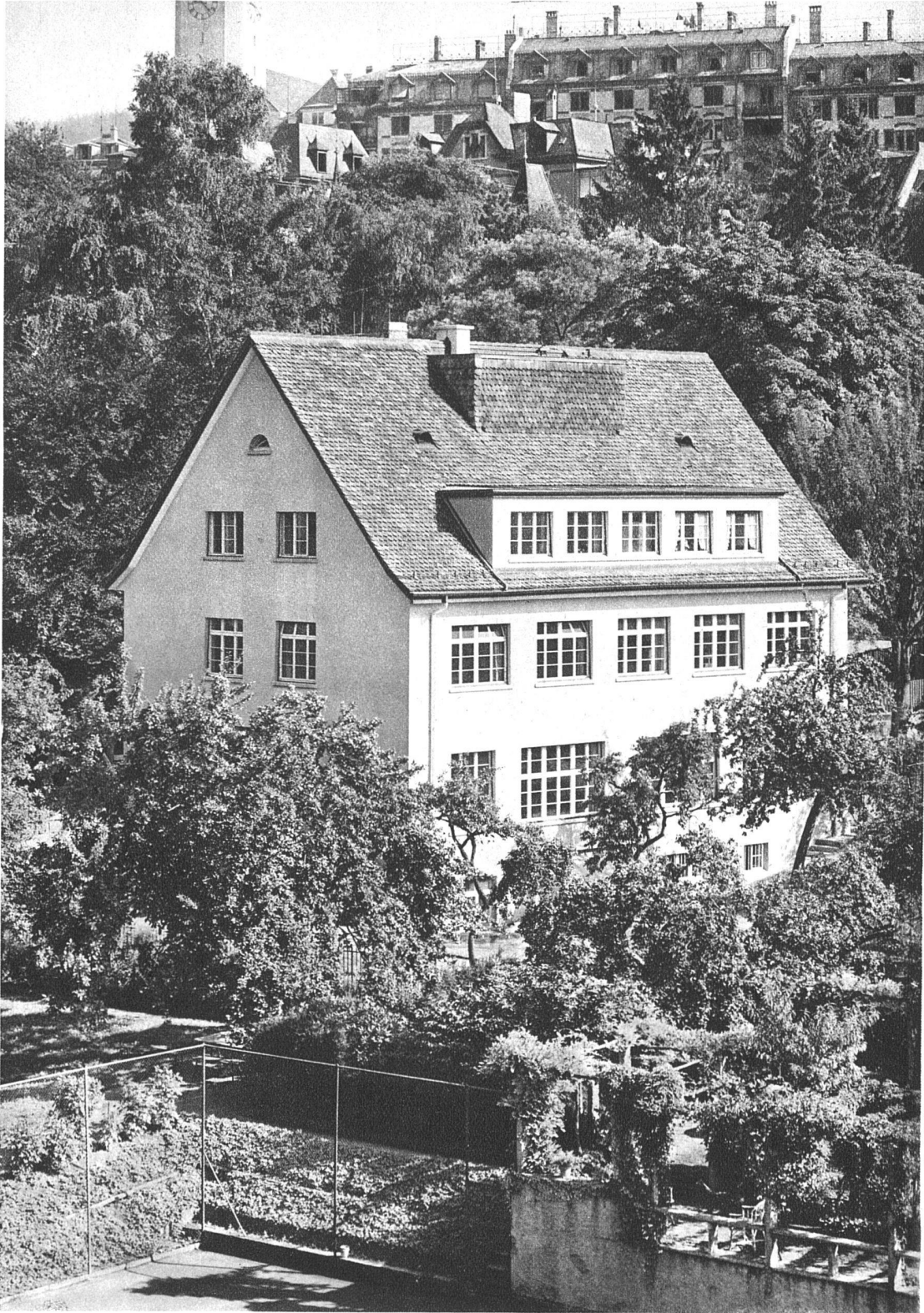
Das Geobotanische Forschungsinstitut Rübel an der Zürichbergstrasse, Zürich, erbaut 1928—1929 Ansicht aus Süden gegen die Kirche Fluntern Architekt Richard von Murali BSA, Zürich
