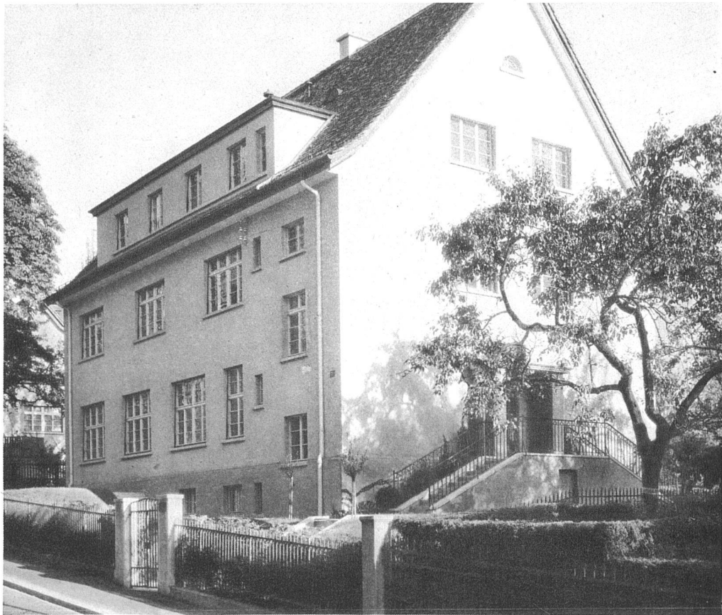
Geobotanisches Institut Rübel Ansicht aus Westen (von der Zürichbergstrasse) Architekt Richard von Murali BSA, Zürich
