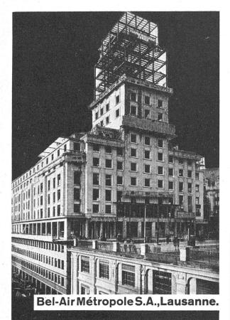
Dieser Grossbau, ein geschweisstes Stahlskelett, unten Geschäftsräume, oben Wohnräume, im Unterbau ein Kino. Namhafter Nutzraumgewinn ergab sich in der Bauweise mit Stahl und Leichtbaustoffen aus den geringern Konstruktionsquerschnitten gegenüber andern Bauarten. Hervorragend isolierend gegen Schall und Wärme. 2000 Tonnen Stahlkonstruktion.
