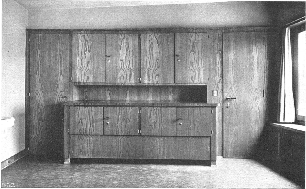
Wohnhaus Professor Otto R. Salvisberg BSA an der Restelbergstrasse, Zürich Eingebaute Schränke im Atelier Esche hell, rechts Türe zur Garage, Boden graugrün Linoleum, Decke weiss
