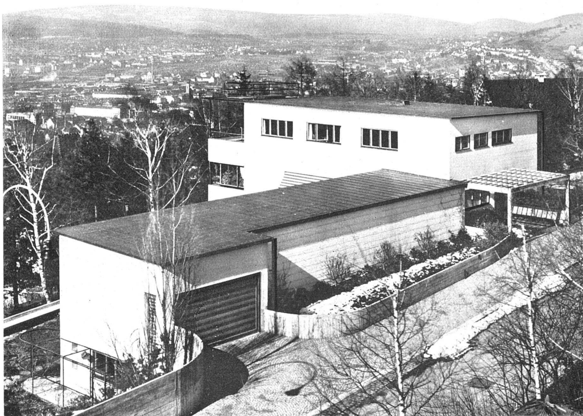
oben: Haus Salvisberg aus Osten gesehen, im Vordergrund die Restelbergstrasse. Flachdach mit Kupfer gedeckt unten: Hauseingang mit Eisenbeton-Pergola, offener Vorgarten, Zugang Melserplatten, Haustüre Zeburanholz mit Einfassung aus dunkler Keramik
