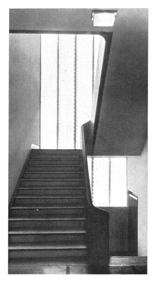
Treppe der Südflügel mit durchgehendem Kopflicht der zweiseitig bebauten Flure Material: Gummibelag blau-weiss, Treppenbrüstung blau Emailfarbe (Honsalin), Wände weiss, Fenster durchgehend, Glasprismen zwischen Eisenbetonpfeilern Entlüftung über Dach
