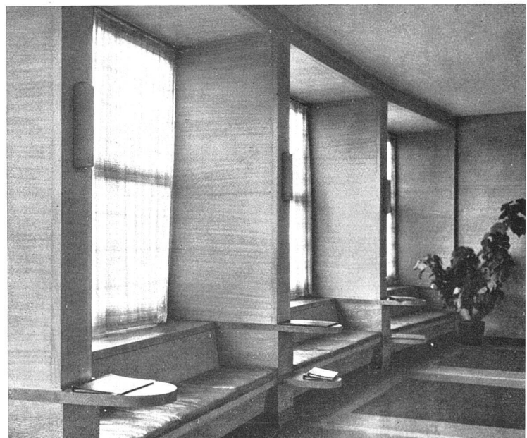
Fensterwand mit Sitznischen und Ablagetischen in der Schalterhalle Wände und Fensterpfeiler mit Fledwood-Fournier-Tapeten bekleidet
